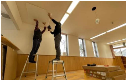
超軽量不燃天井材を施工する様子
