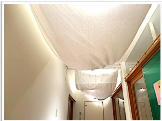
布状吸音材を防災素材で覆って吊るした様子
